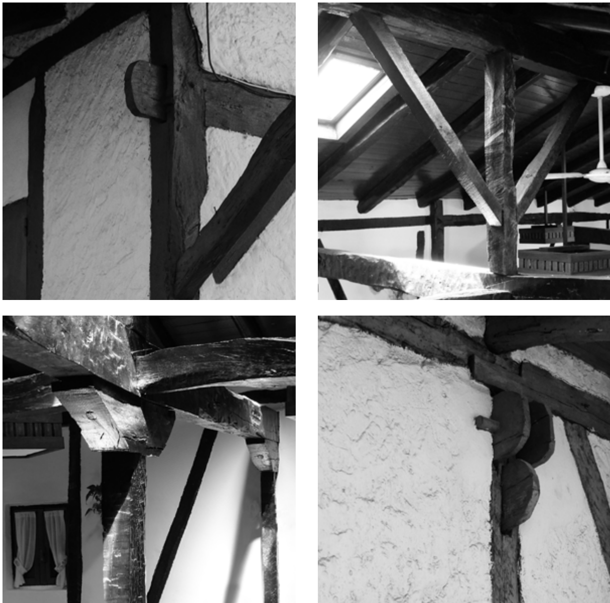
Figura 11: Detalles de la estructura de madera. (01) Ángulo entre la fachada principal y lateral, (02) Montante y puntales de la cumbre, (03) Apoyo de los postes con zapata, (04) Unión en espiga entre las vigas y los montantes de la fachada lateral.
