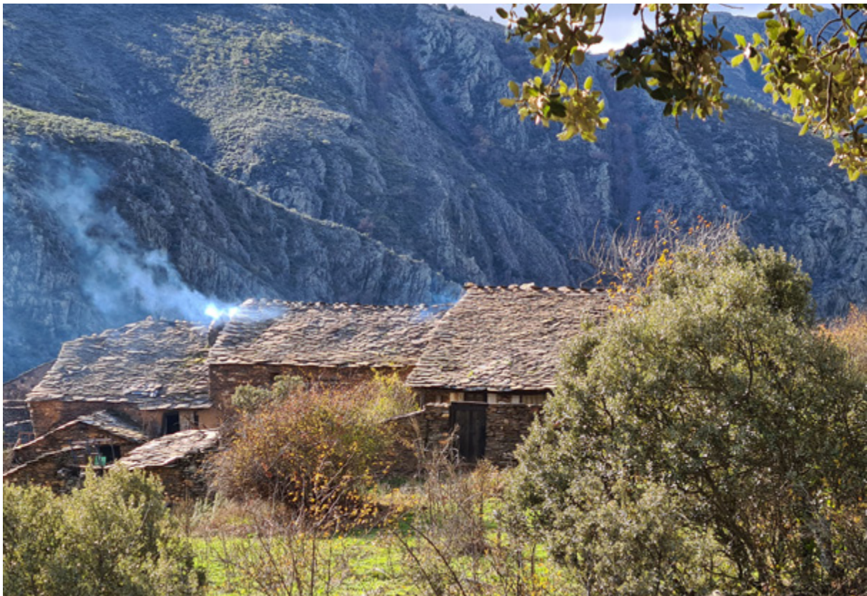
Figura 8: Grupo de viviendas escalonadas del área sur de La Vereda. El humo de las chimeneas proporciona el aroma a leña característico del lugar
