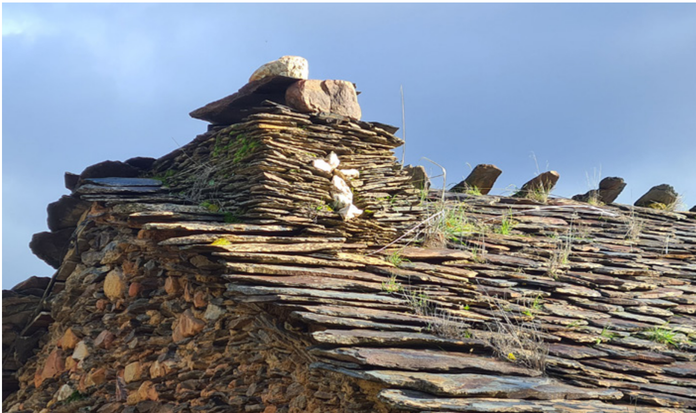
Figura 9: La Vereda. Detalle de cubierta, con su remate característico en forma de tijera y una chimenea de morfología tronco-piramidal
