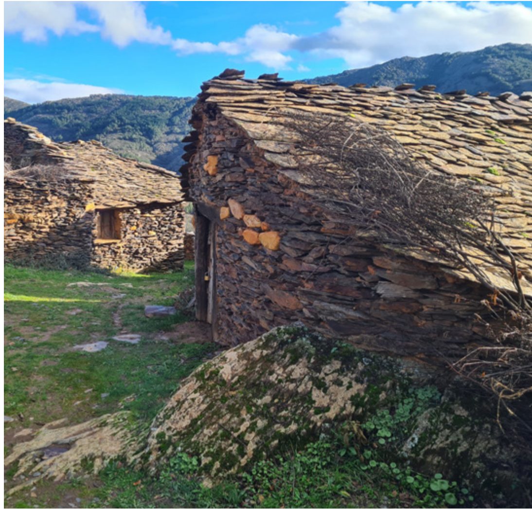
Figura 7: Una casa apoyada directamente sobre la roca en La Vereda
