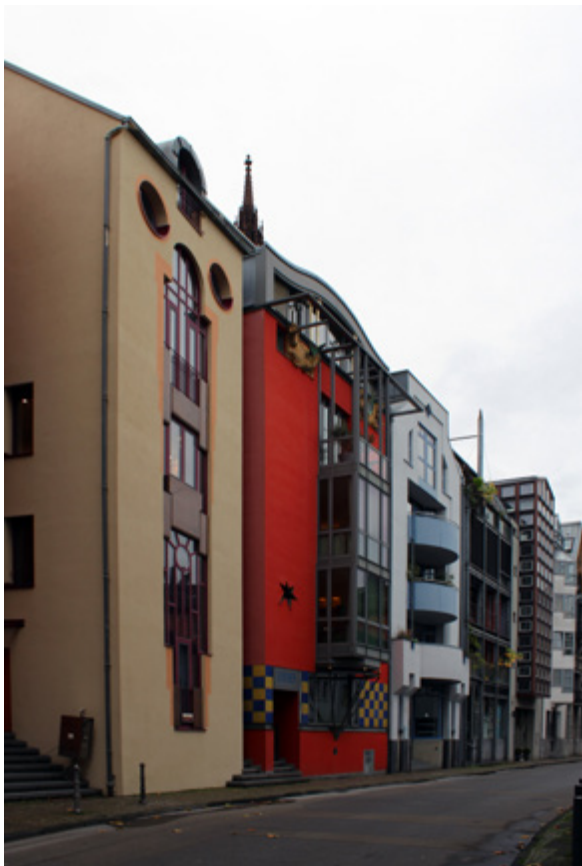
Figura 8: Viviendas posmodernas de la calle Saalgasse
