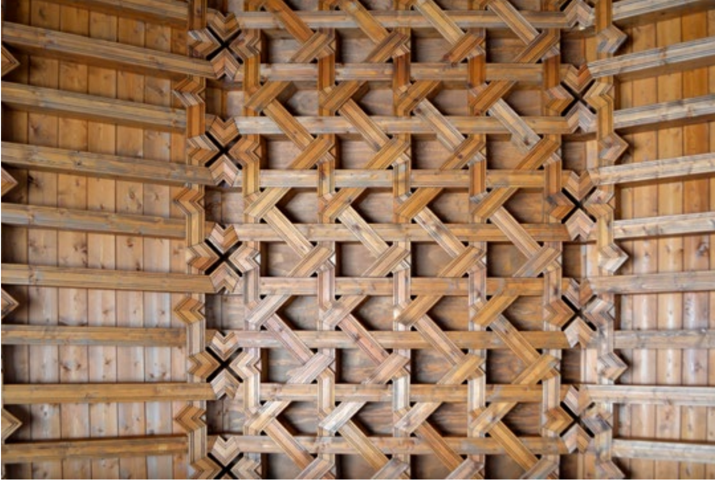
View from below of the ceiling with detail of the almazate upper surface with characteristic Leonese bands and crosspieces forming jagged or pointed azafate polygons | Vista inferior de la armadura de cubierta de la ermita con el detalle del almazate y el característico lazo apeinado leonés de azafates quebrados o harpados | Vista inferior do telhado com um detalhe da superfície superior do almazate e o característico entalhe Leonês com polígonos azafate dentados ou pontiagudos (Pablo Sevilla)
