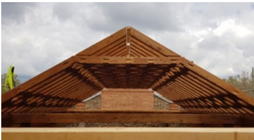
Front view of the collar-beam roof structure | Vista frontal de la armadura de par y nudillo de la ermita | Vista frontal da armação de par y nudillo da ermida
