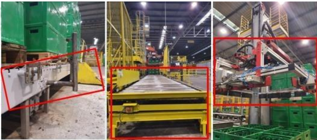
Figura 8 - Substituição dos suportes laterais do transporte de palete e cabeçote
