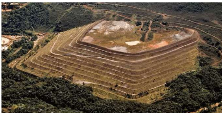
Figura 20 - Empilhamento Drenado do Xingu, Mina de Alegria da Vale.
