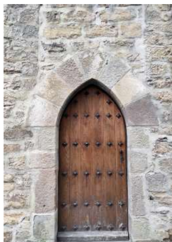
Puerta de la sacristía de la parroquia Santiago, abierta con las piedras del arco procedente de la casa de Nicolás Navallas, calle Santiago 21.
