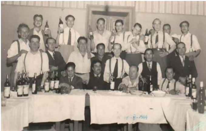
Figura 3. Cena de ferroviarios en San Bernardo, 1944
