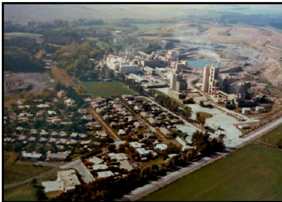
Figura 2. Foto satelital de la empresa Calera Avellaneda S.A. y su villa obrera von Bernard, año 1975.
