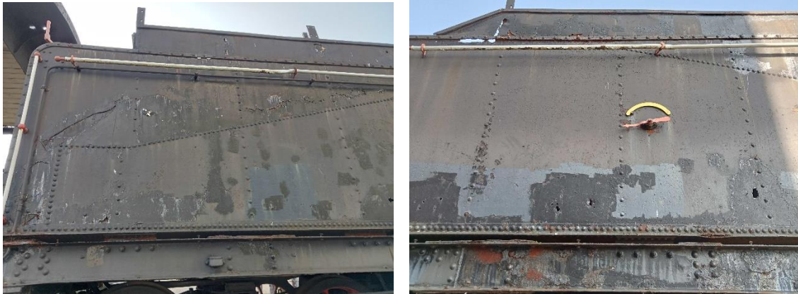
Figura 13: Detalles del deterioro de los mamparos metálicos del tender. Delaminaciones, estado de los remaches metálicos (izquierda) y pérdida de elementos constitutivos originales (Fotografías del autor).
