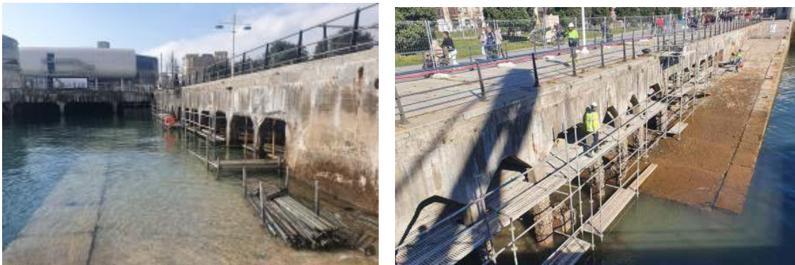
Figura 25: Colocación de andamios y escaleras de acceso al muelle (Fotografías de [8] y del autor).
