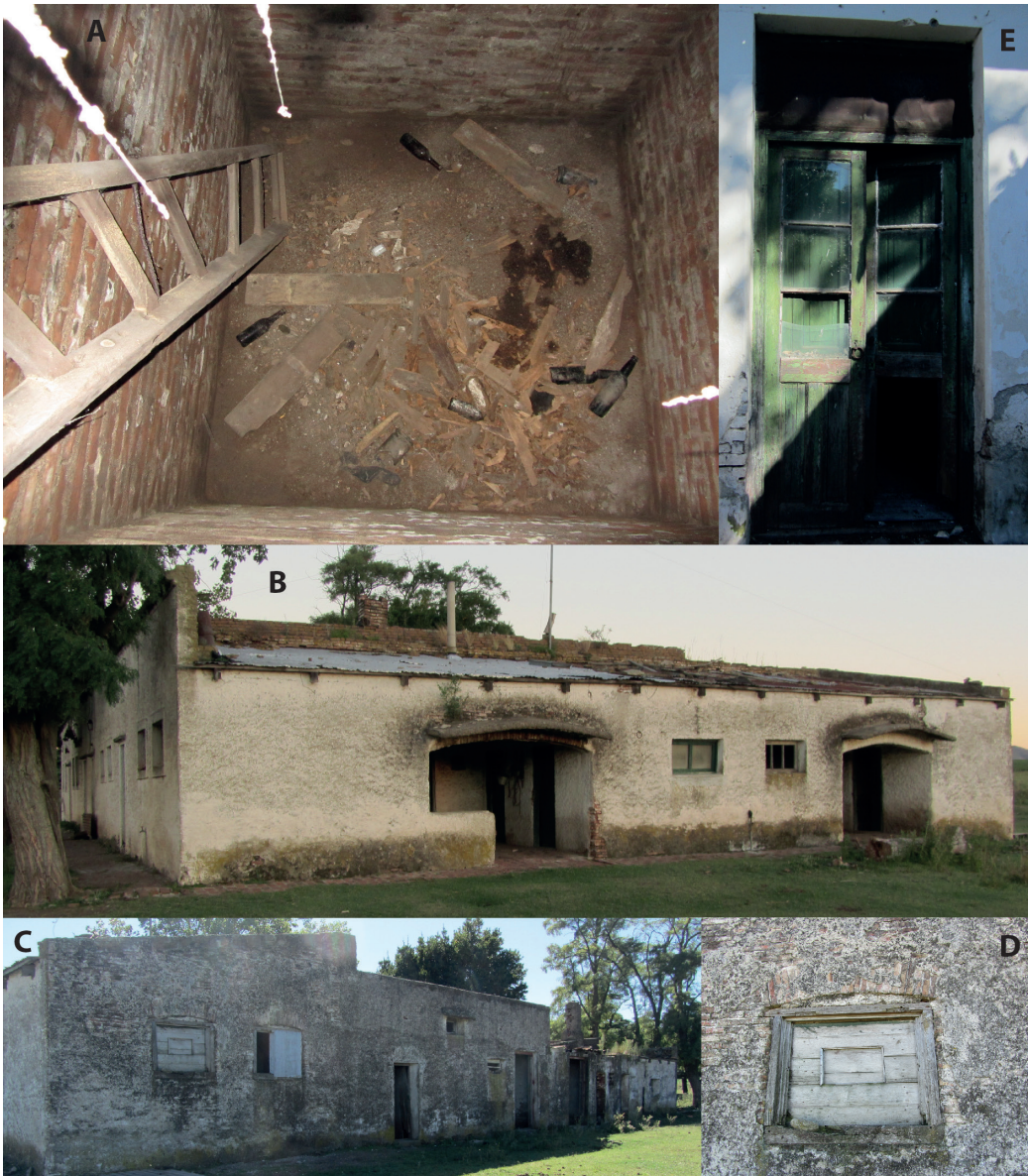
Figura 5. Detalles de San Carlos. A) Sótano con paredes de ladrillo, restos de escalera de madera. B) Lateral oeste de la construcción, detalle de teja y guardapolvos sobre las entradas. C) Contrafrente, se observan los dinteles rectos y las aberturas con sus guardapolvos. D) Detalle de ventana. E) Puerta de dos hojas con paños vidriados y banderola superior.
