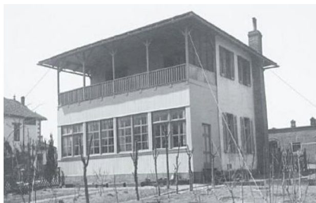
Figura 5: Casa prefabricada de madera donde residían los colonos (1899). Fuente: Colonialism and Modern Architecture in Germany (Osayimwese, 2017).
