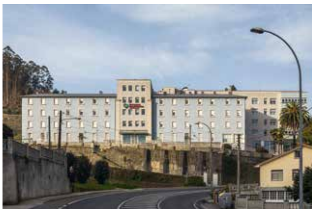
Fig 10.- Vista del centro Pai Menni tras la última reforma. Vemos el cartel con el nombre actual, Hermanas Hospitalarias Centro Pai Menni, el cuerpo central del edificio ha ganado altura, quedan como vestigio del edificio original las dos columnas laterales y ha desaparecido la escalera de entrada. Se ven los contrafuertes y los muros con las imágenes del Antiguo y Nuevo Testamento.
