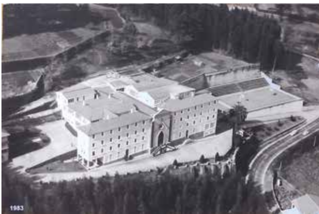
Fig 9.- Vista aérea del Refugio en 1983, cuando llevaba diez años reformado. Se observa que el edificio original ha sufrido transformaciones ampliándose en altura los dos edificios laterales, desapareciendo las figuras existentes en la cima del mismo, en la base de la doble escalera de subida a la capilla y entrada principal había una hornacina donde estaba la imagen de Santiago Apóstol.
