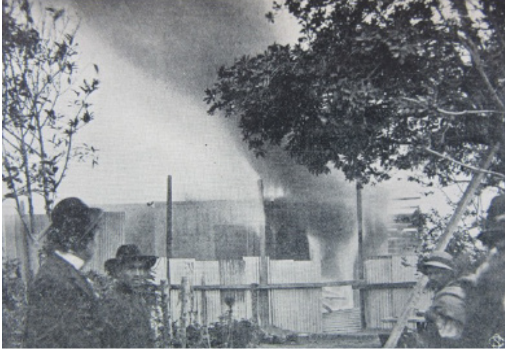
Figura 3. Incendio de casa de “apestados” de Mollendo
