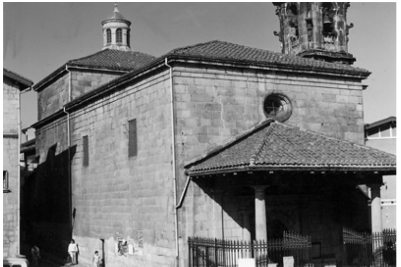
8. Vista del conjunto del exterior de la Basílica de Lezo.
