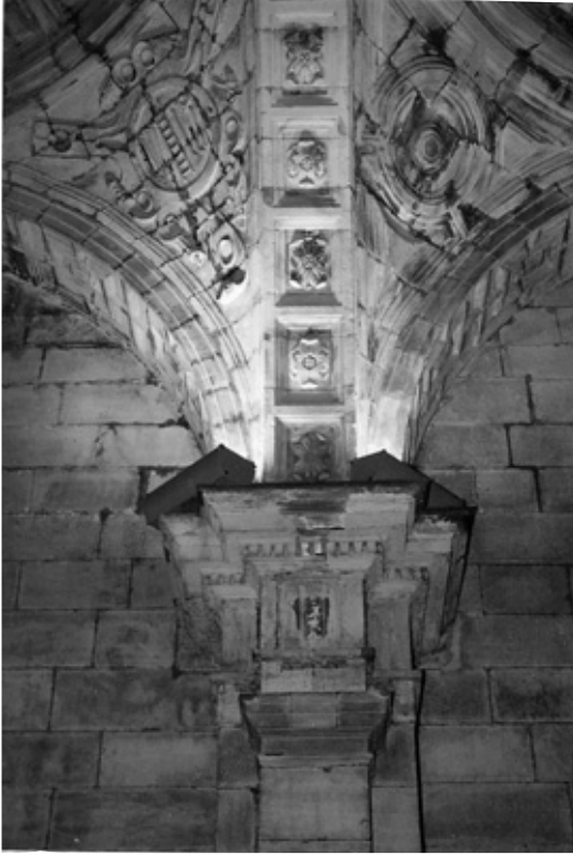
15. Detalle del entablamento de remate de los soportes y arranque de los arcos del sistema de cubrición de la Basílica. Pedro de Zaldúa. (1608-1619).
