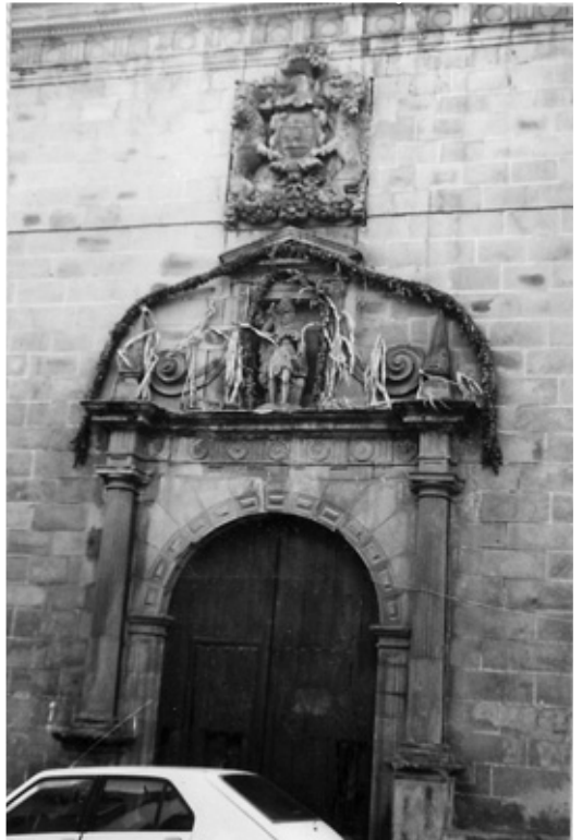
12. Portada del Hospital de San Juan Bautista en Oyarzun. (Guipúzcoa). Primer cuarto del siglo XVII.
