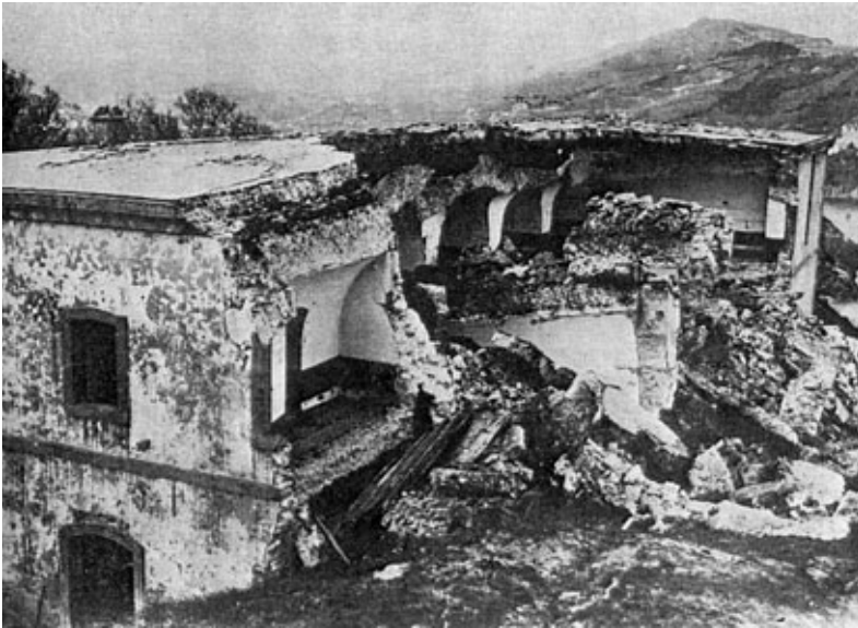
Cuartel a prueba en la plataforma alta del Urgull. El derribo costó la vida al Capitán Irio, cuando trataba de efectuar la voladura con dinamita. Año 1921. (II. n.º 75).
