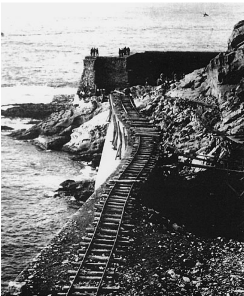
Obras en el tercer tramo. Foto Archivo Iñaki Aguirre.
