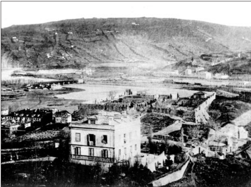
Palacete rural de Beloca, que estaba situado en la que hoy es zona deportiva del Colegio Marianistas. Detrás San Bartolomé, sin el antiguo Convento ya que fue destruido en la 1ª guerra carlista. (Fototeca Kutxa)
