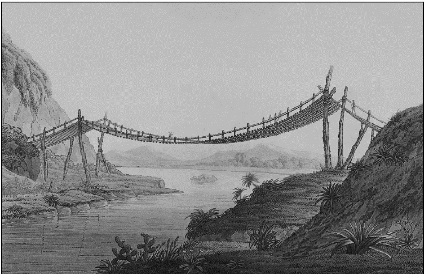
Figura 6: Dibujo del puente chimba-chaca sobre el río Chambo, Ecuador. Tomado de Humboldt (1878), lámina XXXIII.
