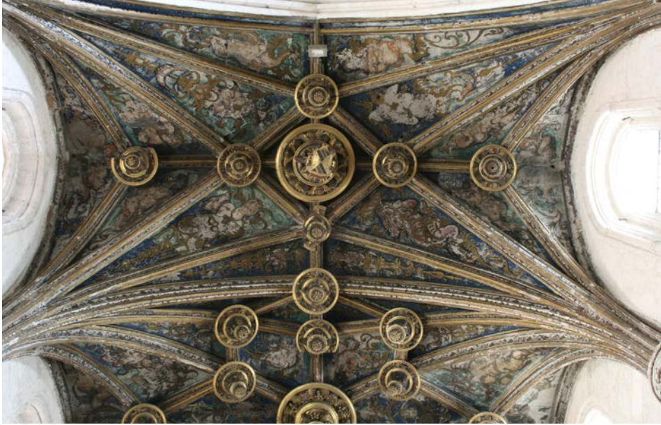
Detalle de la bóveda del segundo tramo de la capilla mayor
