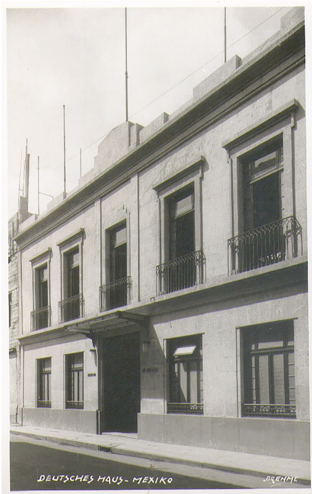
Figura 1. Fachada del Casino Alemán
