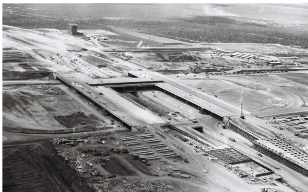
Imagem 2. Operações de terraplanagem na construção da Rodoviária do Plano Piloto de Brasília
