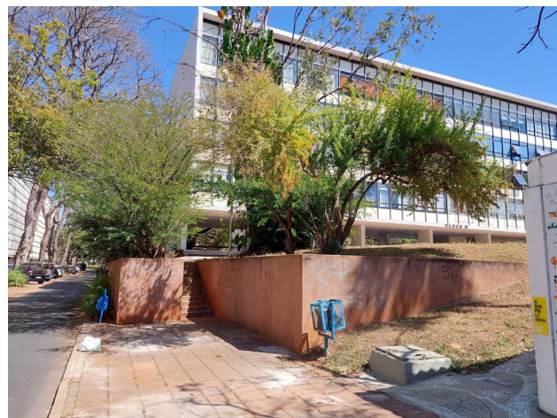
Imagem 3. Operações de terraplanagem e ajardinamento na Superquadra de Brasília, com taludes, arrimos e escadas
