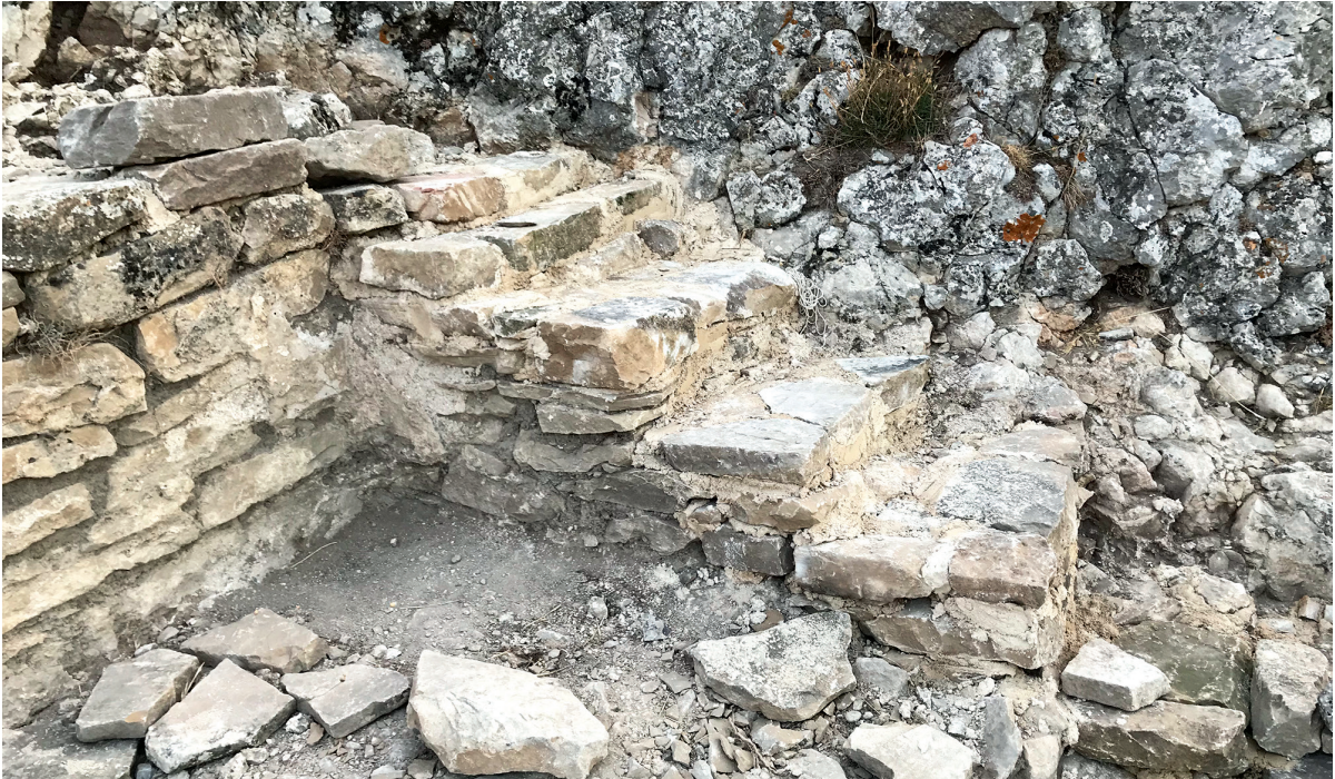
Figura 9. Recomposición del muro este para evitar su deterioro.
