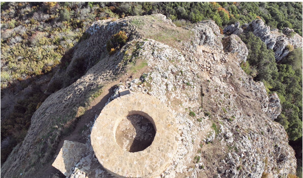
Figura 5. Vista cenital de la torre. El achatamiento hacia el norte se hace patente al ser parte del muro antiguo de la torre y que nos sugiere una planta que se adapta a la roca, con una zona recta hacia el norte.
