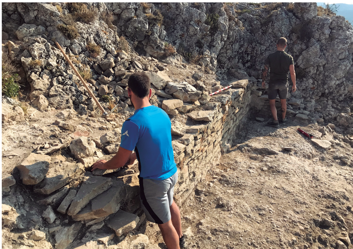
Figura 7. Proceso de montaje de piedra de la pared norte del aljibe.
