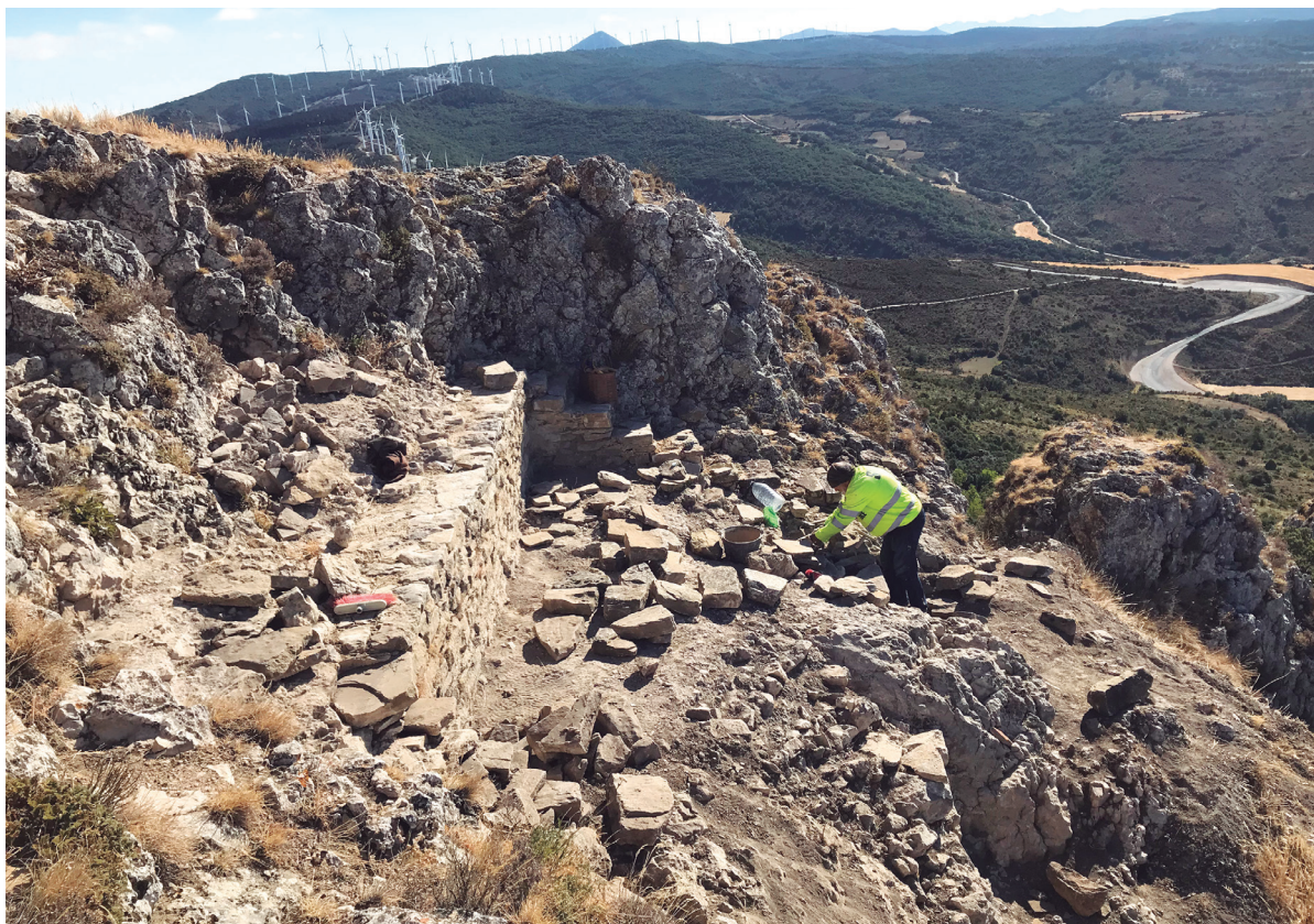
Figura 8. Reconstrucción del muro este para evitar su deterioro.
