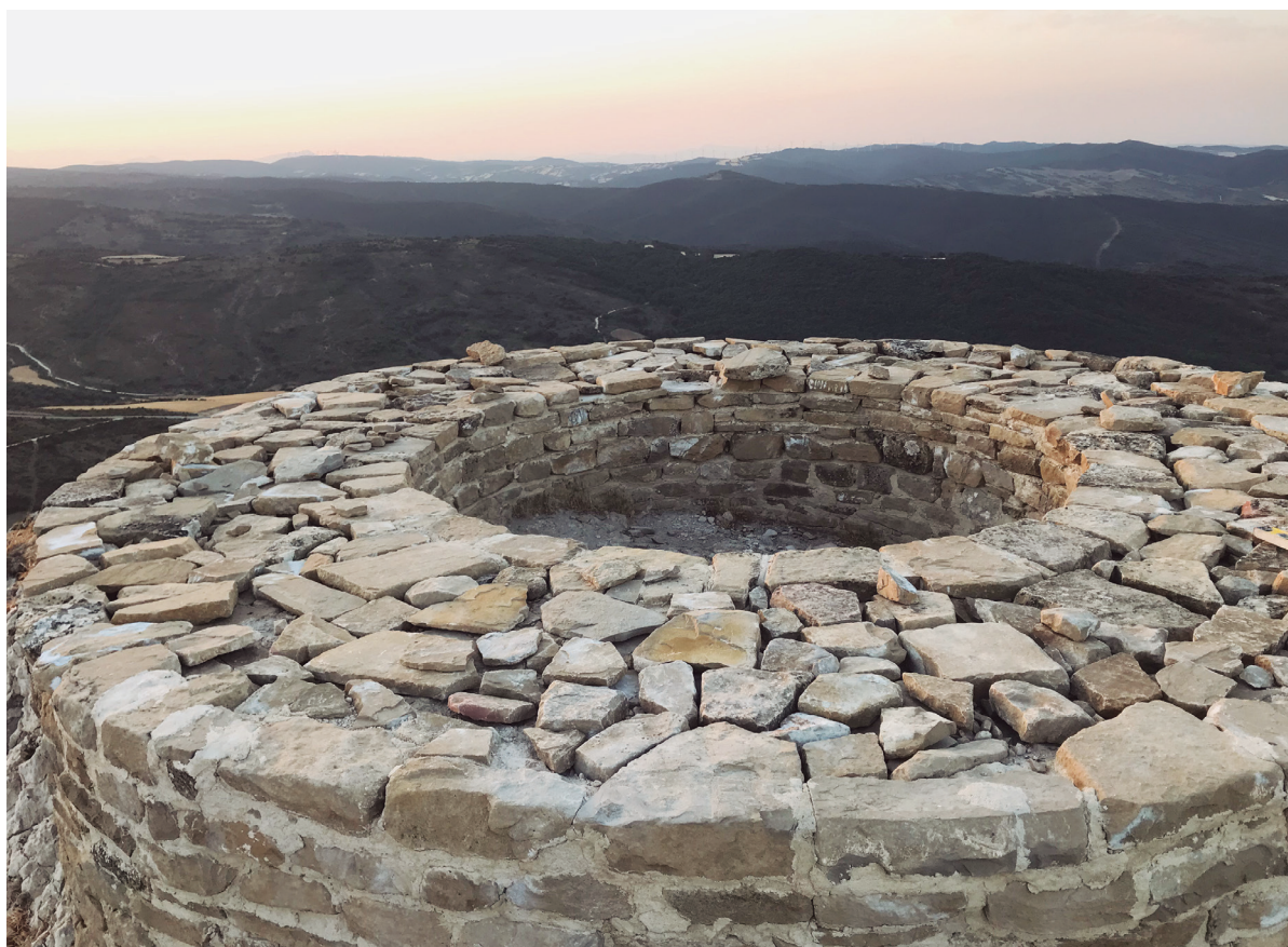
Figura 2. Torre con las piedras de losa niveladas previo al trabajo de aplicación de argamasa.
