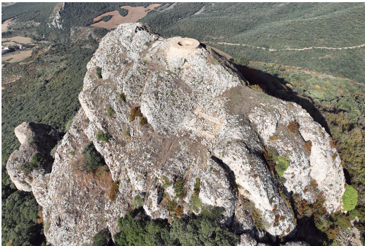
Figura 1. Torre y elementos del castillo consolidados.
