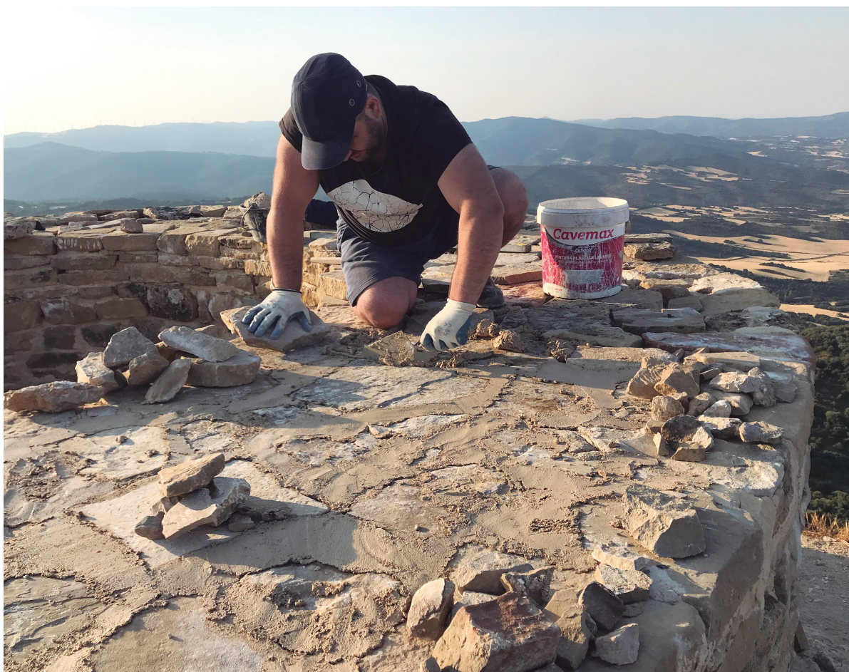
Figura 3. Proceso de colocación de argamasa y rejuntado final para el cierre. El fin es evitar la entrada de agua al interior del muro de la torre.
