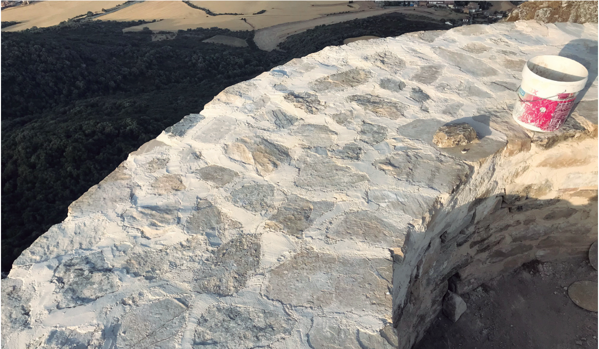
Figura 4. Acabado de la torre tras su cepillado.
