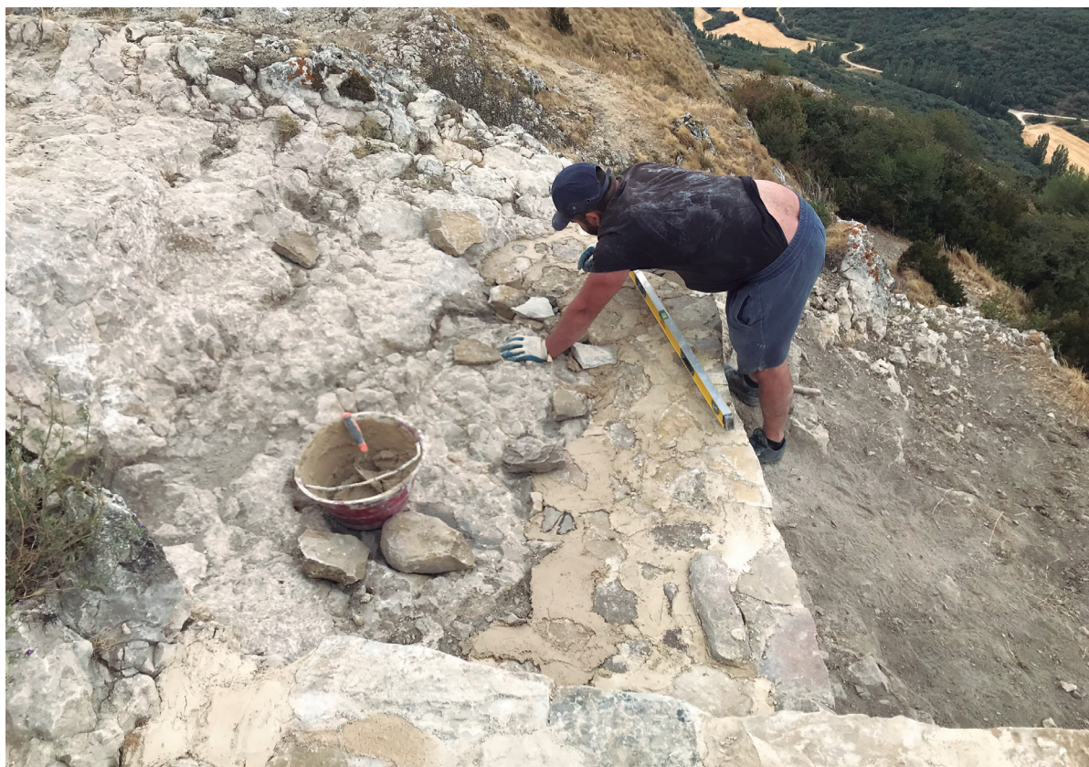
Figura 6. Proceso de consolidación de la dependencia anexa a la torre.
