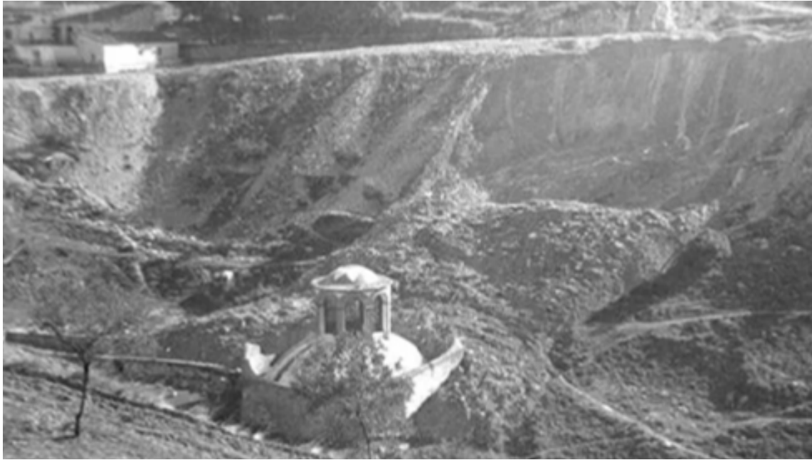
Fotografia 3. Despreniment de vessant a la font del Molinar degut a un abocament de terres.
