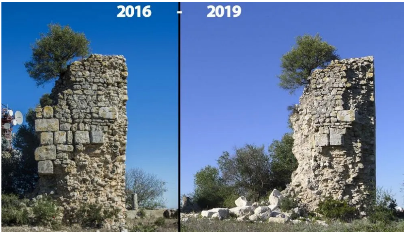
Figura 1. La torre de Gibalbín, en dos fotos comparativas, de 2016 y 2019. Fuente
