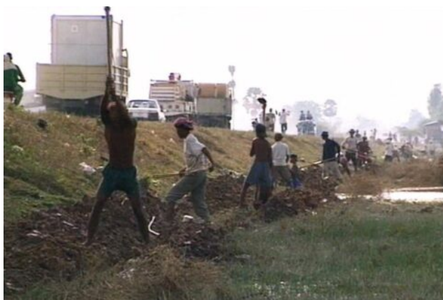
Fotograma de La terra de les ànimes en pena, documental dedicat als jornaleros itinerants que en condicions precàries estenen per la companyia francesa Alcatel el cable de fibra òptica a través d'una Cambodja on un passat atroç jeu encara enterrat a poca fondària.
