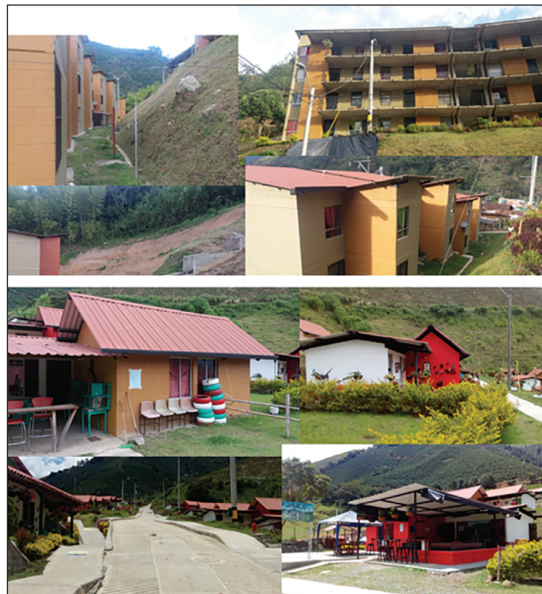
Figura 1. Fotos de los proyectos de reconstrucción de vivienda (La Florida y La Pradera)
