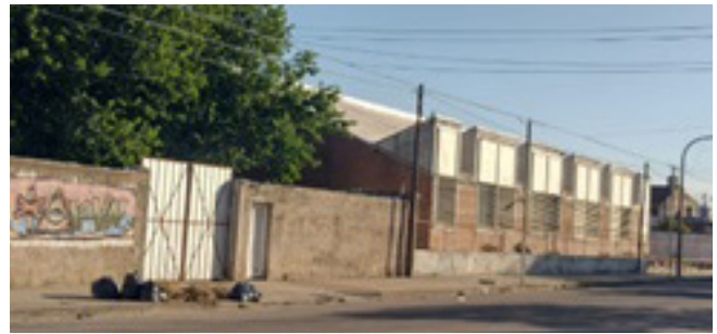
Figura 5. Las instalaciones del Hogar, vista desde esquina Dorrego hacia calle Cerrito, noviembre 2022.
