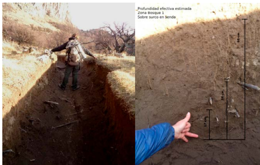
Figura 3. Procesos erosivos en el primer kilómetro de la senda al Fitz Roy (julio de 2018)
