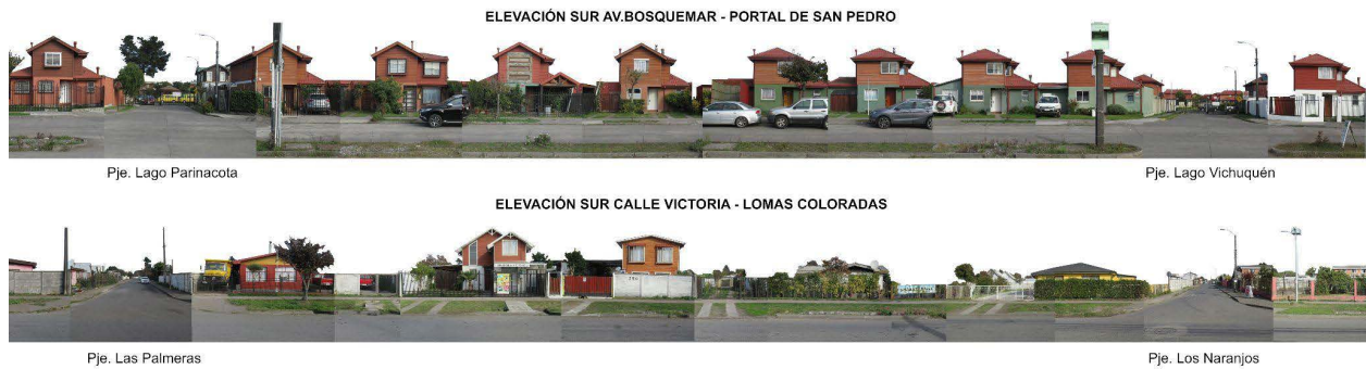
Figura 3. Elevación entorno construido; Portal San Pedro (arriba) y Lomas Coloradas (abajo). Fuente: Elaboración de los autores.
