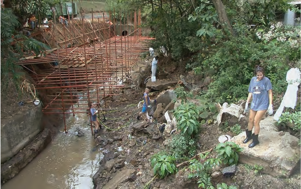
Figura 13. Inicio de obras civiles en la locación elegida para el montaje Río Pirro
