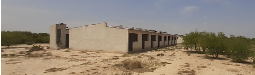
Fig. 3. Complejo habitacional para jornaleros en la comunidad de Buenavista, Villa de Arista, San Luis Potosí.
