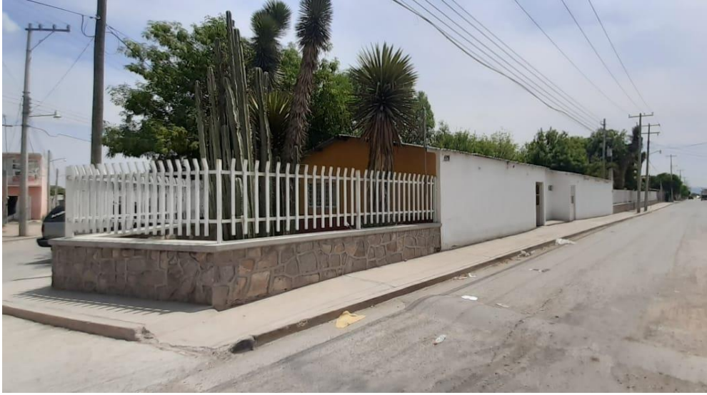
Fig. 6. Acceso principal a oficinas administrativas, Albergue Comunitario de Villa de Arista.
