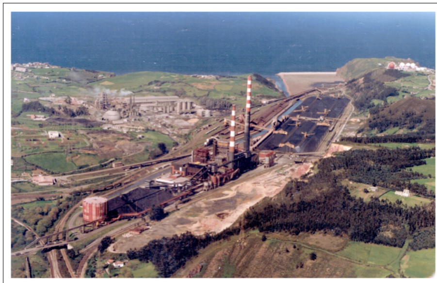
FIG. 5. En la imagen de 1987 se aprecia, en primer plano, la central térmica de Aboño ya ampliada y con la obra del parque de carbones en la desembocadura de la ría; más al fondo, a la izquierda, la cementera de Tudela Veguín. Fuente: archivo fotográfico del concejo de Carreño.
