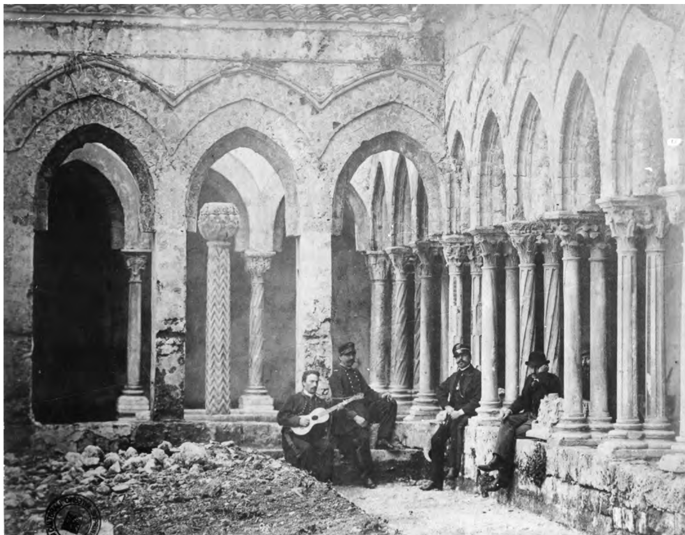
Fig. 4. Fotografia del chiostrino, angolo sud-ovest del chiostro (Archivio fotografico Soprintendenza BB.CC.AA. di Palermo, su concessione dell'Assessorato dei Beni Culturali).
