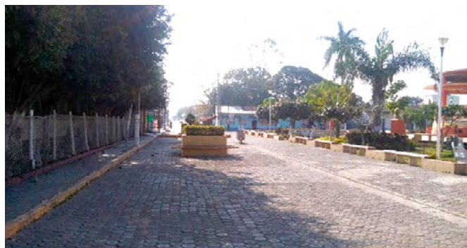
Ⓐ Figura 5. Destrucción del inmobiliario urbano por el paso del huracán Grace. Fuente: elaboración propia (2021).
