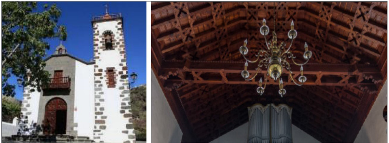
Figura 7.- Ejemplo de pequeña iglesia de las Islas Canarias realizada con fábrica y madera. Ermita de Las Angustias, en los Llanos de Aridane, isla de La Palma. Fotografía de Frank Vincenti.
