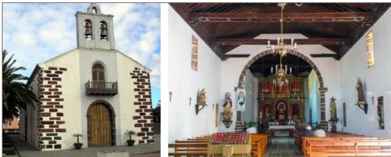
Figura 6.- Ejemplo de pequeña iglesia de las Islas Canarias realizada con estructura de fábrica y entramado de madera. Iglesia del Rosario en la localidad de Barlovento, en la isla de La Palma. Planta con 9 m de ancho y 35 m de largo.
