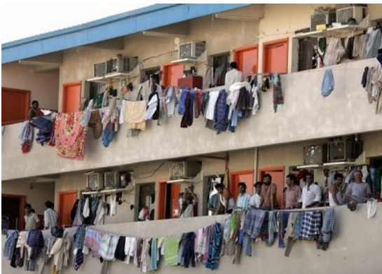
Fig. 8 (A). Residencias de trabajadores. Fig. 8 (A). Worker residences.
