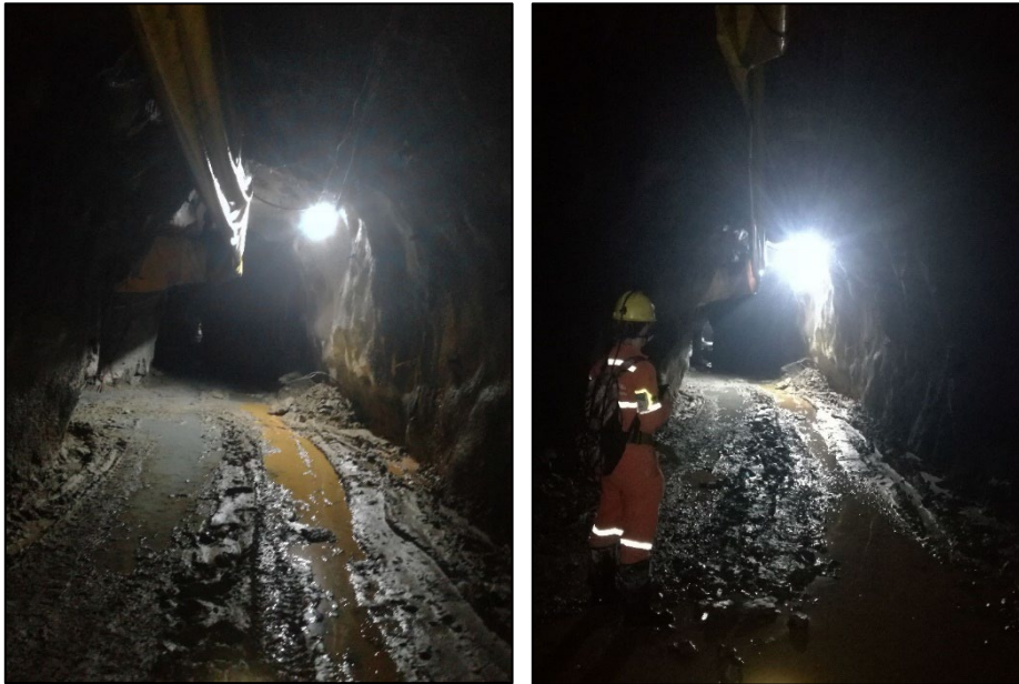
Figura 5. Fotografías túnel guía, área de estudio. Fuente: Los Autores.
