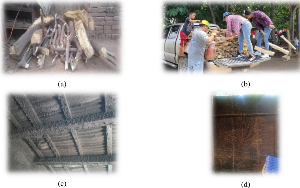
Figura 5. Aspecto de la leña de mesquite almacenada (a), descarga de un vehículo con mesquite (b), hollín impregnado en el techo (c) y pared de una cocina (d). Fuente: trabajo de campo (Santos-Cirilo, 2021).
