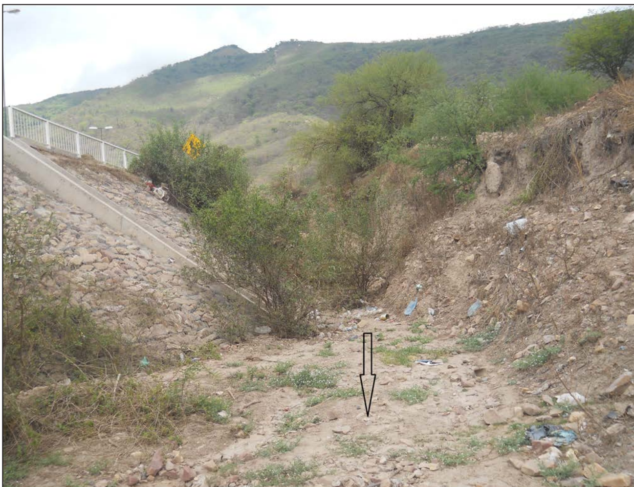
Figura 8. Estribo este del puente del río Arenales y talud norte del ex vertedero.
