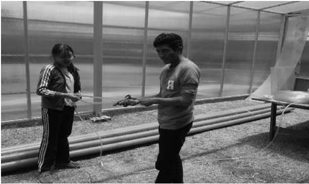
Figura 5. Construcción de la pirámide en el hidropónico piloto de la Escuela. Fuente: autores.
