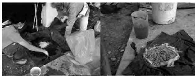
Figura 7. Preparación de la mezcla Fuente: los autores
