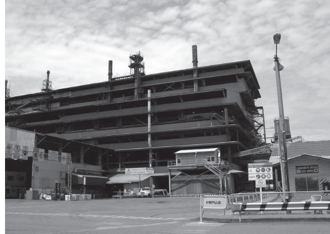
Foto 12. Planta de transformación de ferroníquel (Calcinadora y Horno Cerro Matoso)
