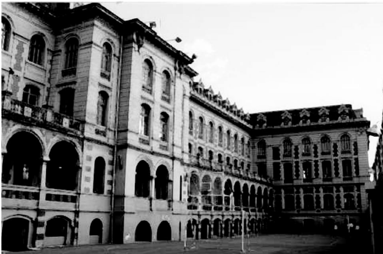
Figura 22- Escuela Central de Artes y Oficios. Instituto Técnico Central. Fachada principal
