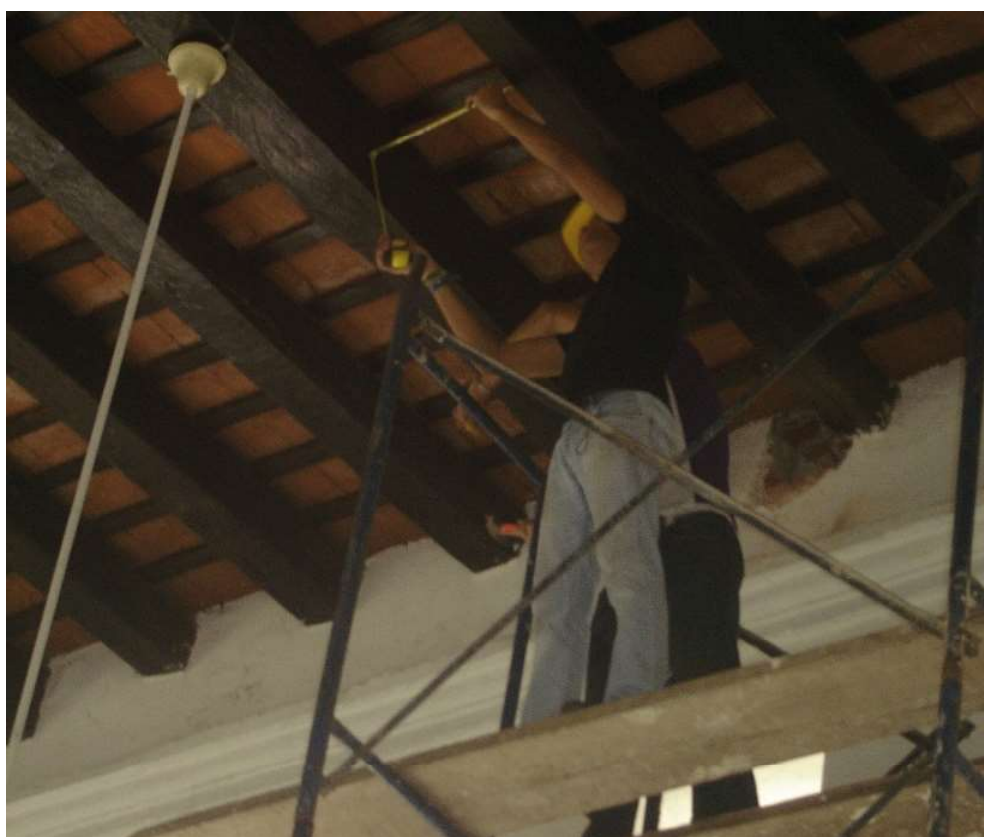
Figura 2. Levantamiento de techo. Método directo. Iglesia del Hospital de San Juan de Dios. Colombia. Fuente: Melero, 2011.
