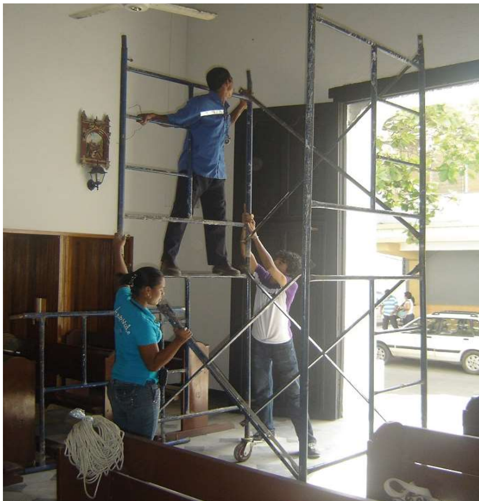
Figura 1. Levantamiento Arquitectónico. Preparación para la toma de medidas. Método directo. Iglesia del Hospital de San Juan de Dios. Santa Marta. Colombia. Fuente: Melero, 2011.
