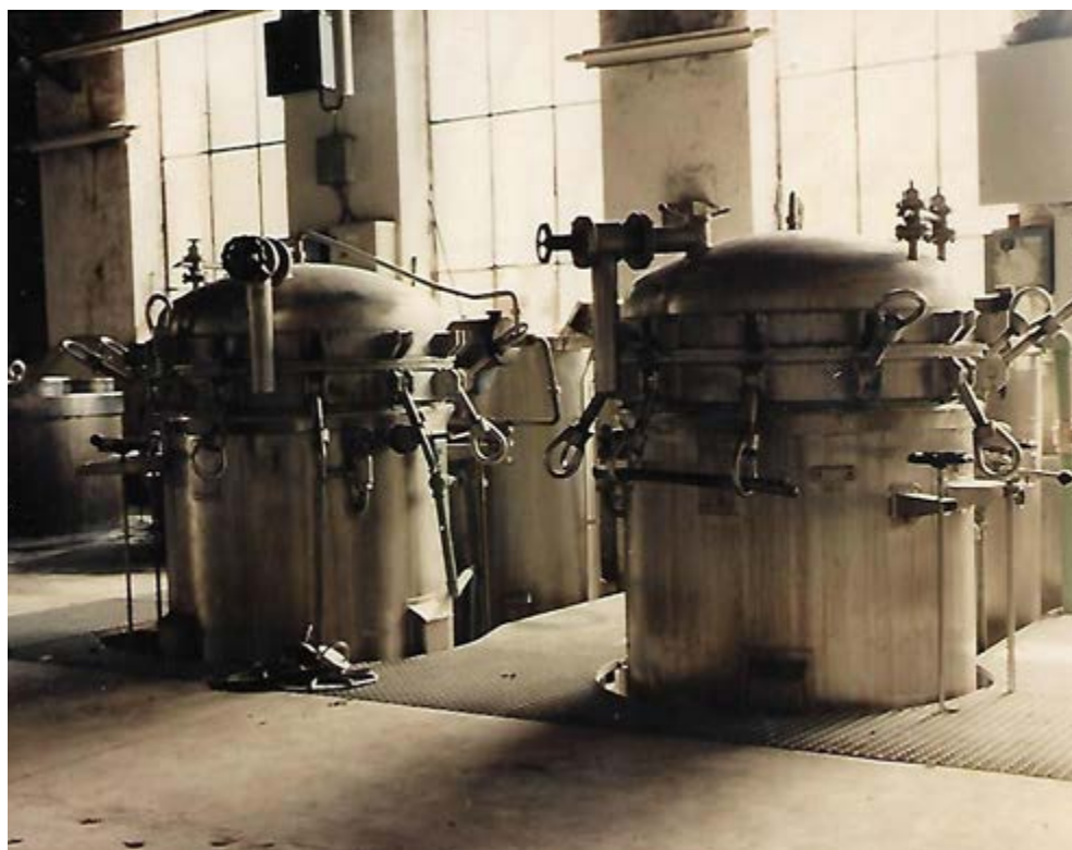
Figura 7. Autoclaves de tintura cerrados, tiñendo la materia textil en el Tinte de Gutiérrez.
