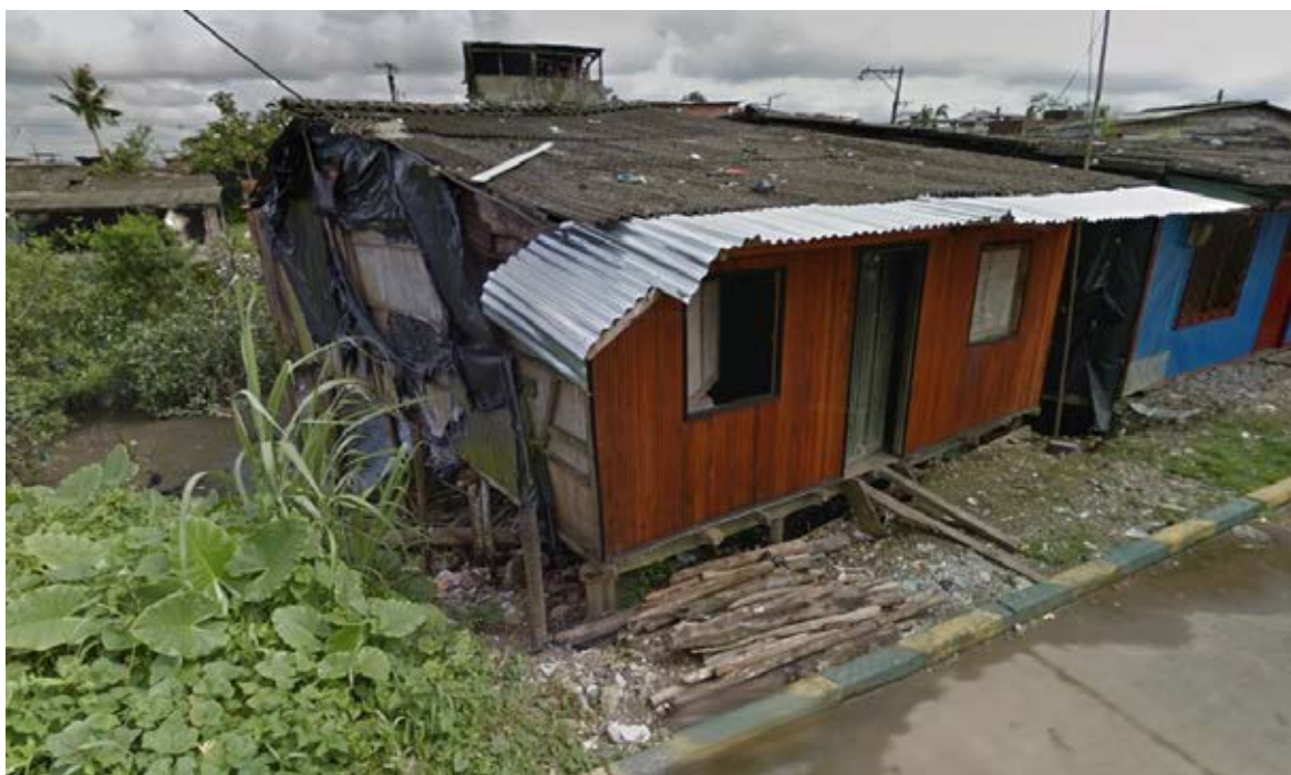
Figura 3. Fotografía vivienda palafítica en la comuna 4 de Buenaventura, Valle del Cauca
