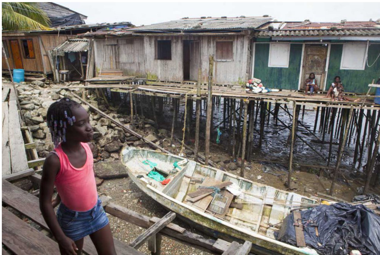
Figura 2. Fotografía viviendas palafíticas en Buenaventura, Valle del Cauca
