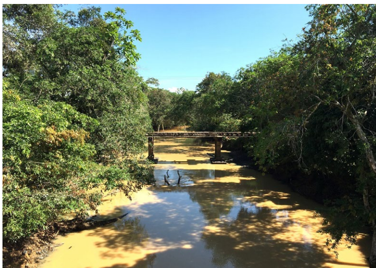
Figura 4. Afectación del río Mandur causada por la minería ilegal de oro en el municipio de Puerto Guzmán, Putumayo.
