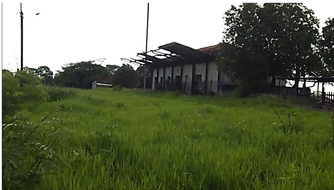
Foto 1. Estação ferroviária abandonada em Álvares Machado/SP.
