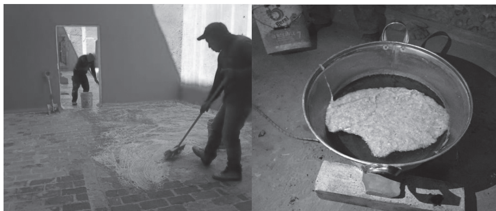
Figura 11. Material de impermeabilización y su aplicación en la losa del Templo de San Agustín.
