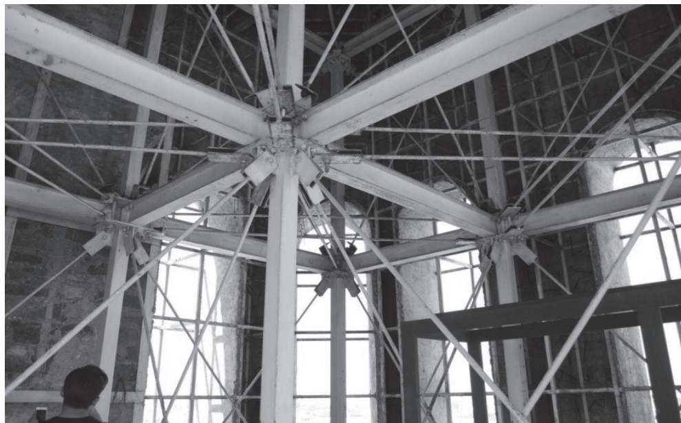
Figura 10. Estructura tridimensional que estabiliza la torre del Templo de San Agustín. Fuente: Máximo (2017).
